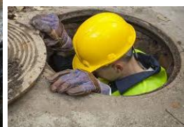
Entretien de réseau par le personnel d'exploitation
